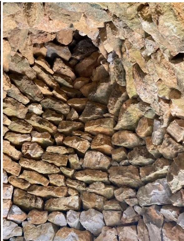
*Blick von innen nach Nordosten (links) und in das in Trockenbauweise errichtete Steingewölbe (rechts), Fotos: Holger Coers*
